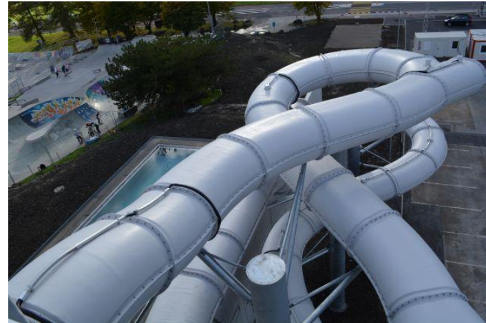
lintharena Näfels, Rutsche Aussenbereich
